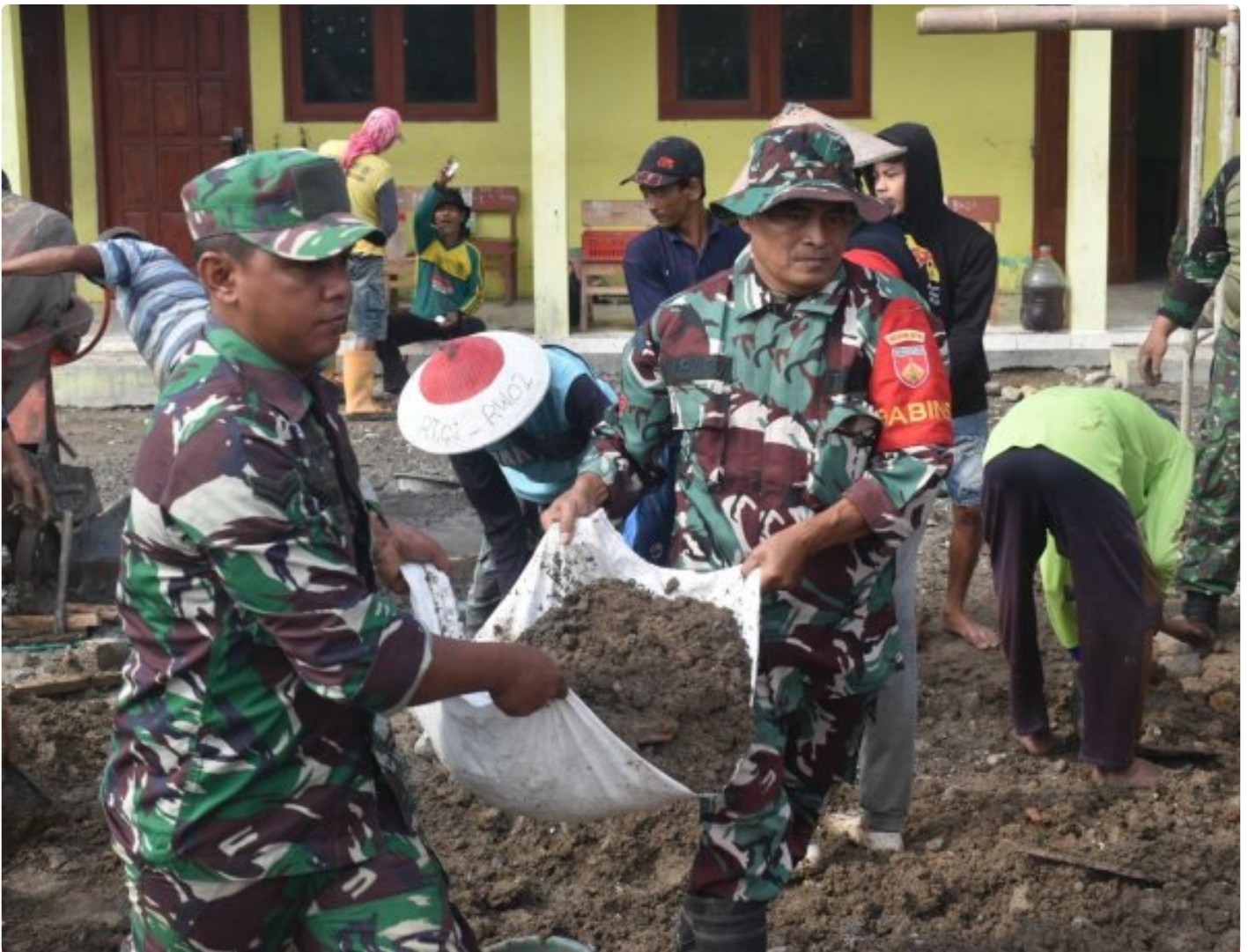
Sambut HUT TNI Ke-79, Kodim 0716/Demak Gelar Karya Bakti Pembangunan Masjid di Desa Solowire
